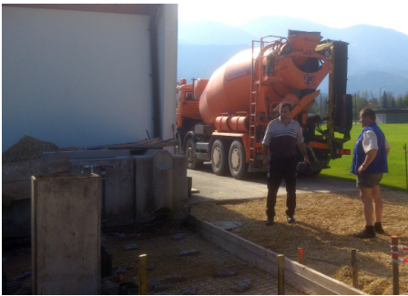
Anlieferung des Betons
