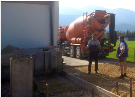
Anlieferung des Betons
